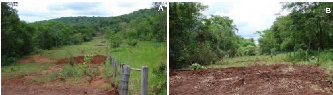
Figura 68. Vista da cerca do fragmento norte da RPPN (unidade à direita nas fotos): A. limite leste (note as curvas de nível e caixas de drenagem); B. limite sudeste.
