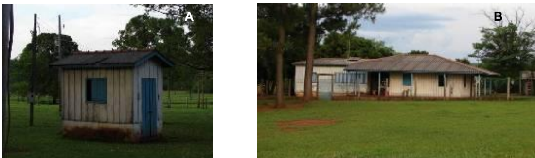
Figura 71. Infra-estruturas da sede: A. casa de máquinas; B. casa principal da sede.
