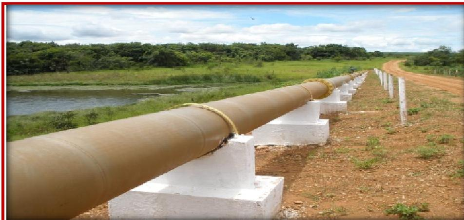
Figura 2. Vistoria à margem do córrego Laranjal (UTM 248634E e 7564910N) na barragem que serve de suporte a adutora da vinhaça.
