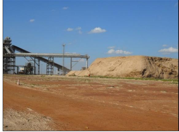
Figura 30 - Pátio de armazenamento de bagaço de cana-de-açúcar para alimentação da caldeira, em períodos com falta de matéria-prima.
