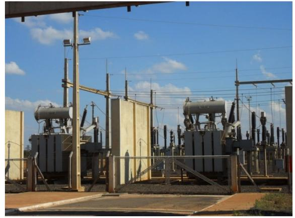
Figura 48 - Subestação de energia elétrica, com transformadores para elevação da tensão.
