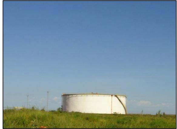
Figura 36 - Tanques de armazenamento de Etanol Hidratado (20.000 m³).
