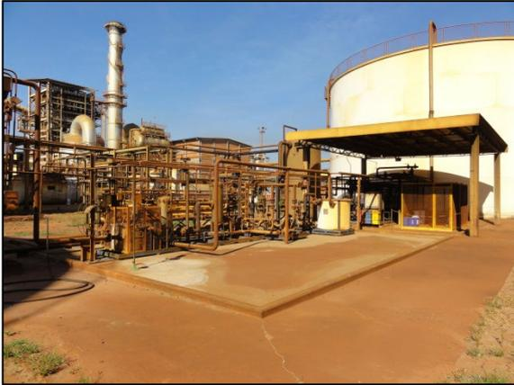
Figura 50 - Estação de Tratamento de Água para a Caldeira.
