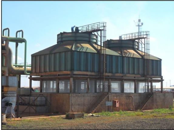
Figura 35 - Torres de resfriamentos das águas utilizadas na destilaria.
