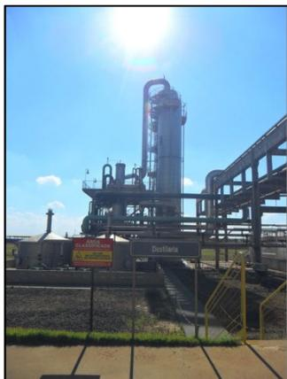
Figura 33 - Aparelho destilador para produção de Etanol Hidratado.
