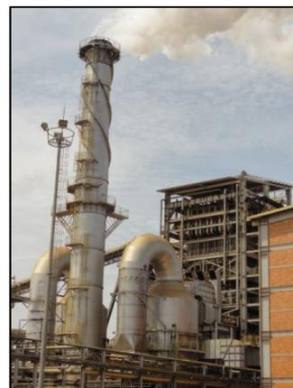
Figura 26 - Caldeira de biomassa utilizada na geração de vapor para a planta industrial e energia elétrica, com capacidade de 275 ton. de vapor/hora.
