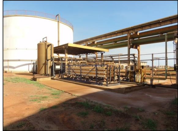
Figura 51 - Sistema de Osmose Reversa para tratamento de água para caldeira (Desmineralização).
