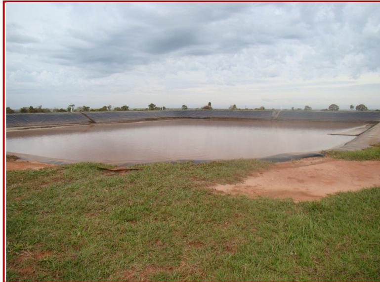
Figura 8 - Tanque de armazenamento de vinhaça e água residuária para posterior fertirrigação das áreas agricultáveis. Fonte: Arater, 2013.
