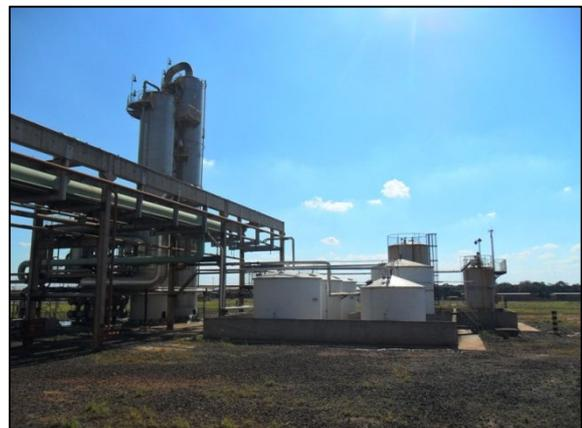
Figura 34 - Armazenamento e expedição de Óleo Fúsel (subproduto da destilaria).
