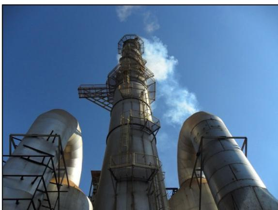
Figura 27 - Lavador de Gases e Chaminé da Caldeira de Biomassa.
