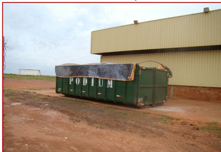
Figura 12 - Caçamba roll on roll off utilizada no armazenamento e transporte dos resíduos Classe II-A. Fonte: Arater, 2013.
